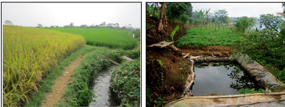
Gambar 5.16. Kondisi eksisting Dam Parit di Sub DAS Cibogo.
