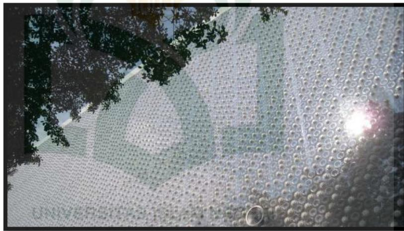
Gambar II.15. Struktur dinding EcoARK
