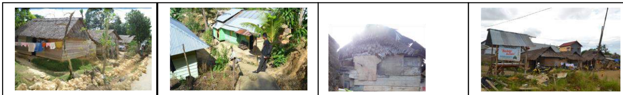
Gambar 2. Kondisi struktur rumah
