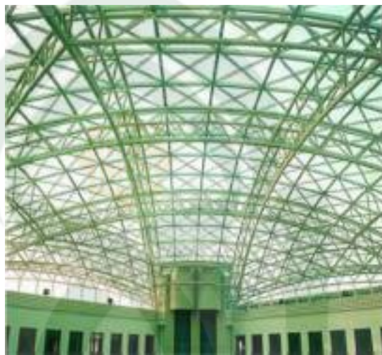
Gambar IV.8 Konstruksi Space Frame
