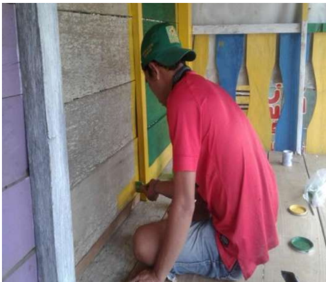
Gambar 3.13 Pengecatan pos ronda
