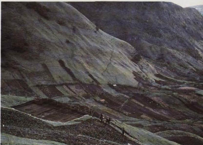
Foto 9 Excavación en terrazas de vivienda.
