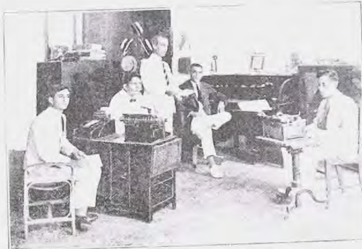
Interior de la oficina del Sr. Salim Bechara, en los bajos de su edificio.
