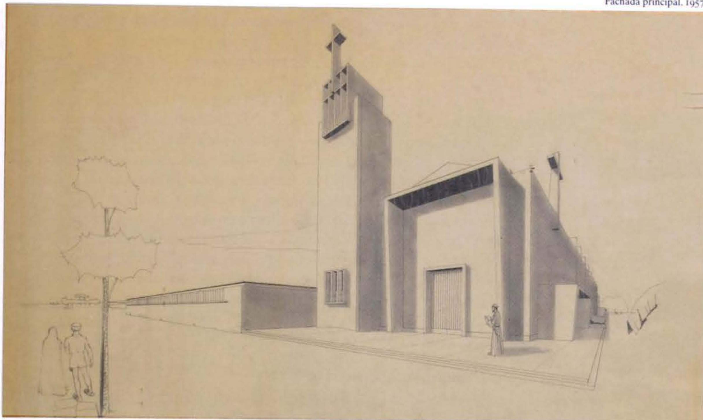
Iglesia salina de Manaure. Fachada principal, 1957.
