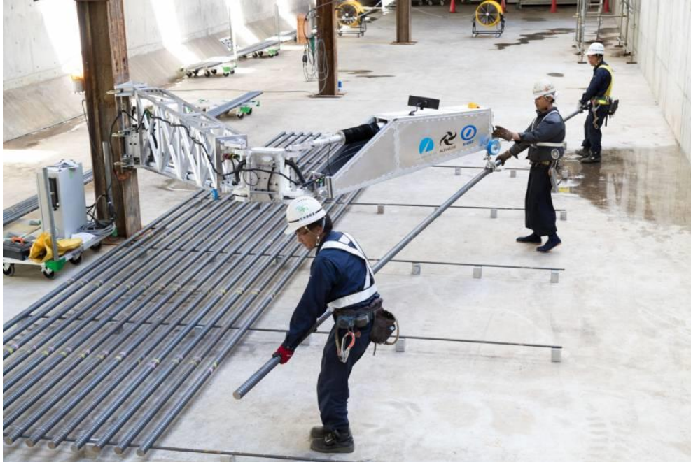
Kuva 37 Robottikäsi auttaa nostamaan 200 kg teräsputkia Shimizun esivalmistetehtaalla 69
