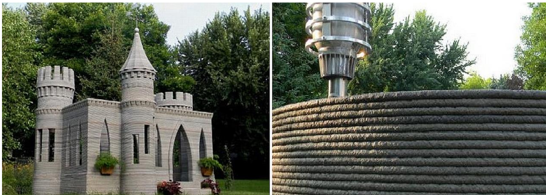
Kuva 36 3D-printattu rakennus ja yksityiskohta printtauksesta 68
