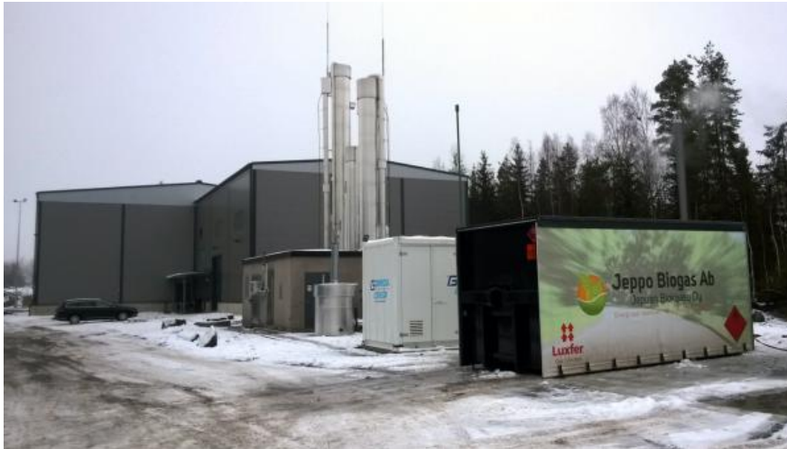
Kuva 4.2. Jepuan biokaasun jalostus- ja paineistusyksikkö sekä kaasukontti maantiekuljetukseen (kuva: Jepuan biokaasulaitos).
