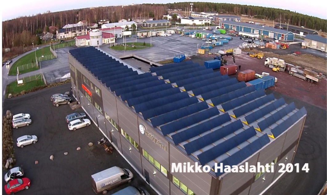
Kuva 6.6. Aurinkopajan kiinteistörakennus. Kuva: Haaslahti Mikko
