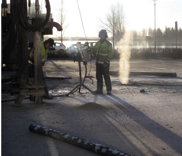
Kuva 3.3. Asfalttilämmönmittauskentän poraukset marraskuussa 2013 Vaasassa. (kuva: Anne Mäkiranta)
