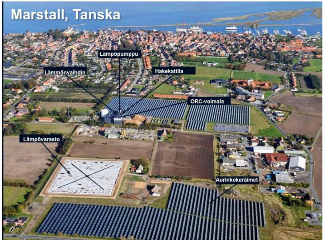
Kuva 6.1. Marstalin hybridivoimala Tanskassa. Marstalin hybridivoimalassa on 15000 m 2 aurinkolämpökeräimiä, 4 MW:n biovoimala yhdistettynä sähköä tuottavaan ORC-voimalaan, 1,5 MW:n lämpöpumppu sekä 75000 kuution lämpövarasto. (Solar District Heating, 2010)
