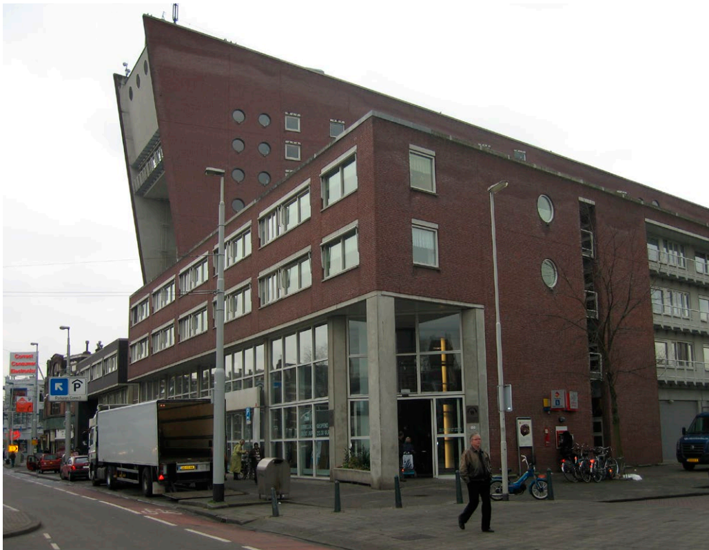
Kuva 17. Humanitas Bergweg -palvelutalo Rotterdamissa.
