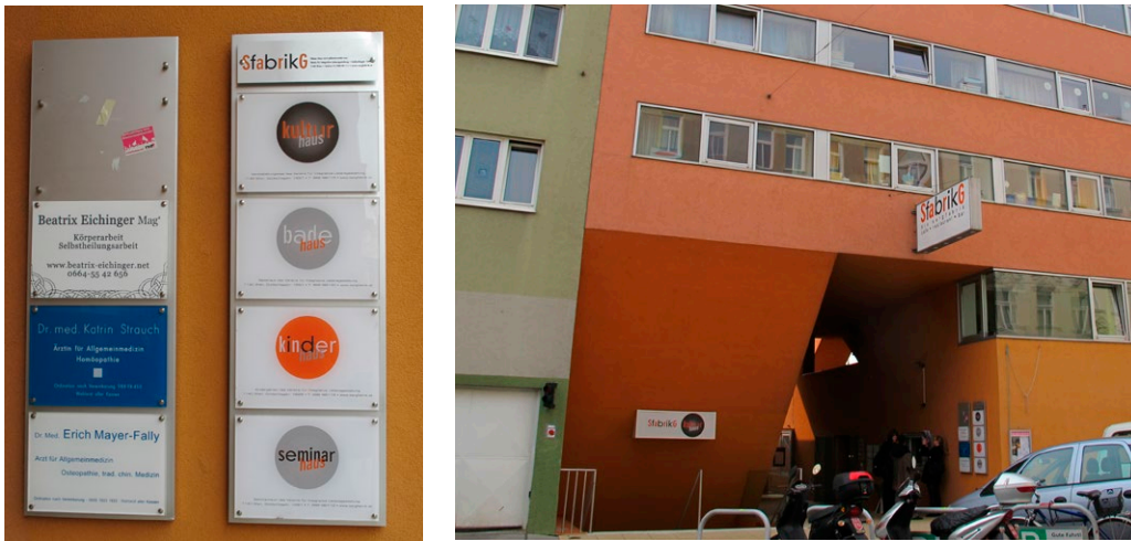
Kuva 40. Sargfabrik-rakennuksessa on runsaasti palvelu- ja toimistotiloja.
