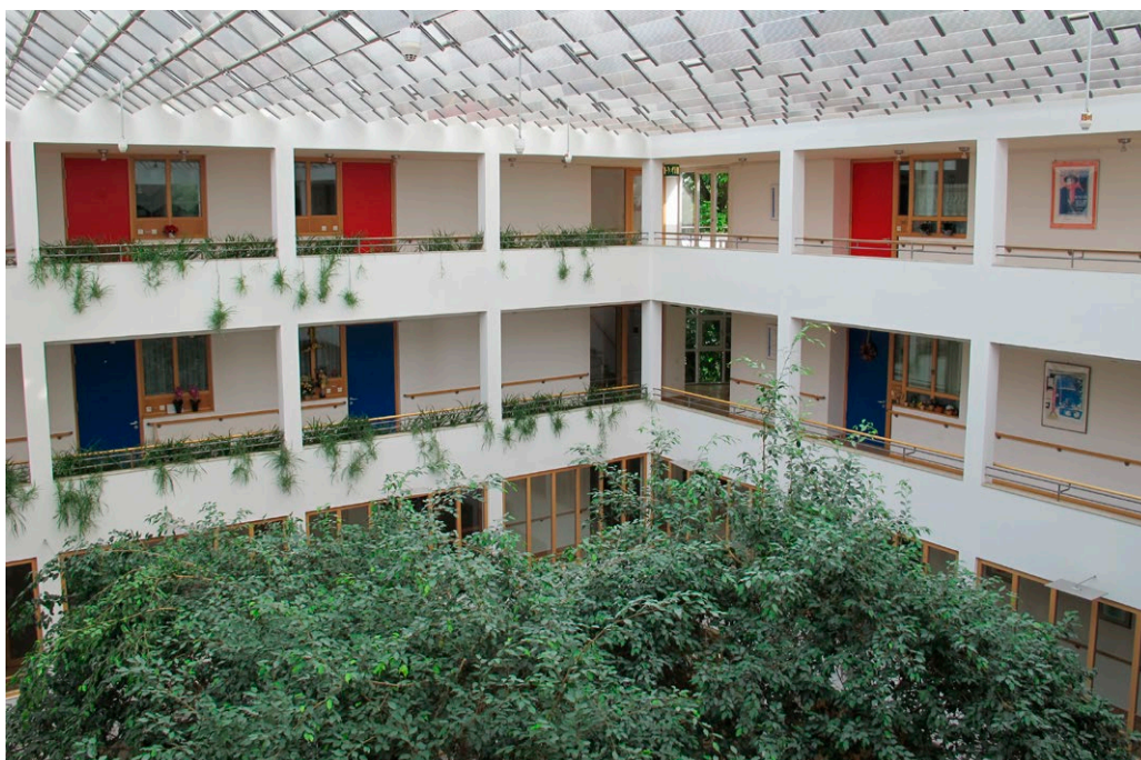
Kuva 30. Rakennuksessa sijaitsevat palveluasunnot avautuvat valoisalle sisäpihalle. Alten Service Zentrum, Eching.
