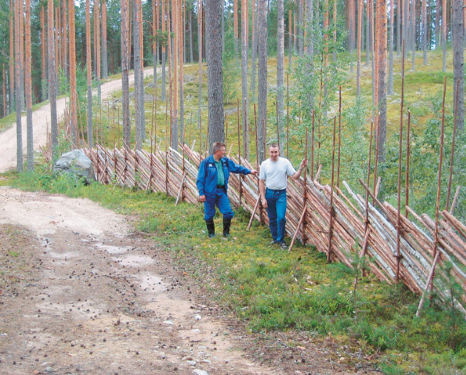
(Ylh.) Suonenjoen Lintharjun ulkoilureitille tehtiin lumiesteeksi pisteaitaa. (Vas.) Taisto Huovinen opetti pisteaidan tekemistä Lintharjulla. Valok. Esko Karvinen.
