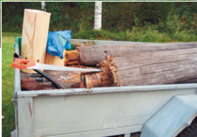
Rautavaaran Metsäkartanolla valopylväiden lahot puukuoret vaihdettiin uusiin. Lopuksi uudet pylväät tervattiin.
