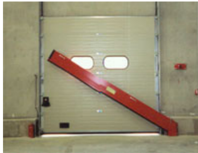
Kuva 20. Oviaukon sulkeminen tulvapuomilla. (Lähde: Jacob Nettekoven)
