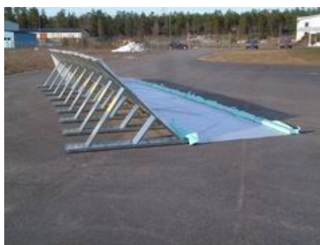
Kuva 7 Steel Barrier -tulvaseinä, korkeus 1,25 m. Oikealla myös vesieristeenä toimiva muovi ja sitä paikoillaan pitävä ketju on asetettu paikoilleen. (Lähde: Geodesign AB)
