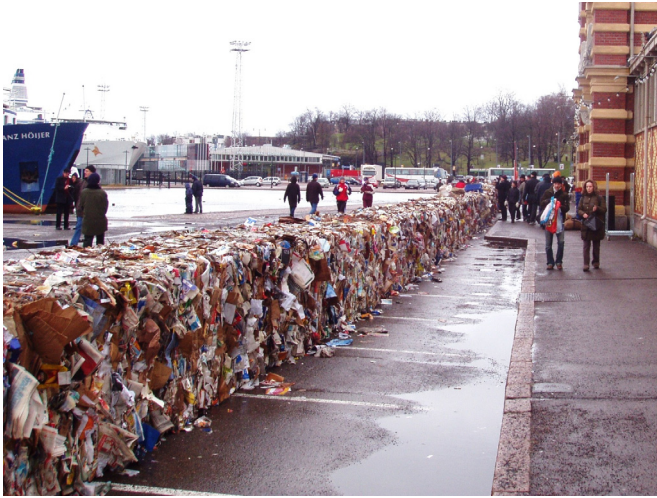
Kuva 6. Suojavalli pahvipaaleista. Kuva: Helsingin kaupungin pelastuslaitos.
