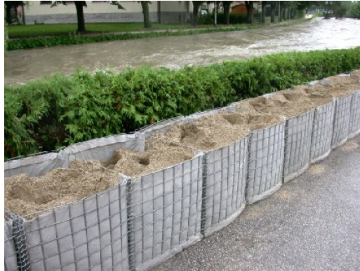
Kuva 4. Hesco Bastion -tulvamuuri. (Lähde: SGS Geotechnik)
