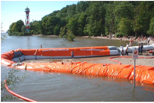
Kuva 15. Mobildeich-tulvamuuri. (Lähde: Mobildeich)
