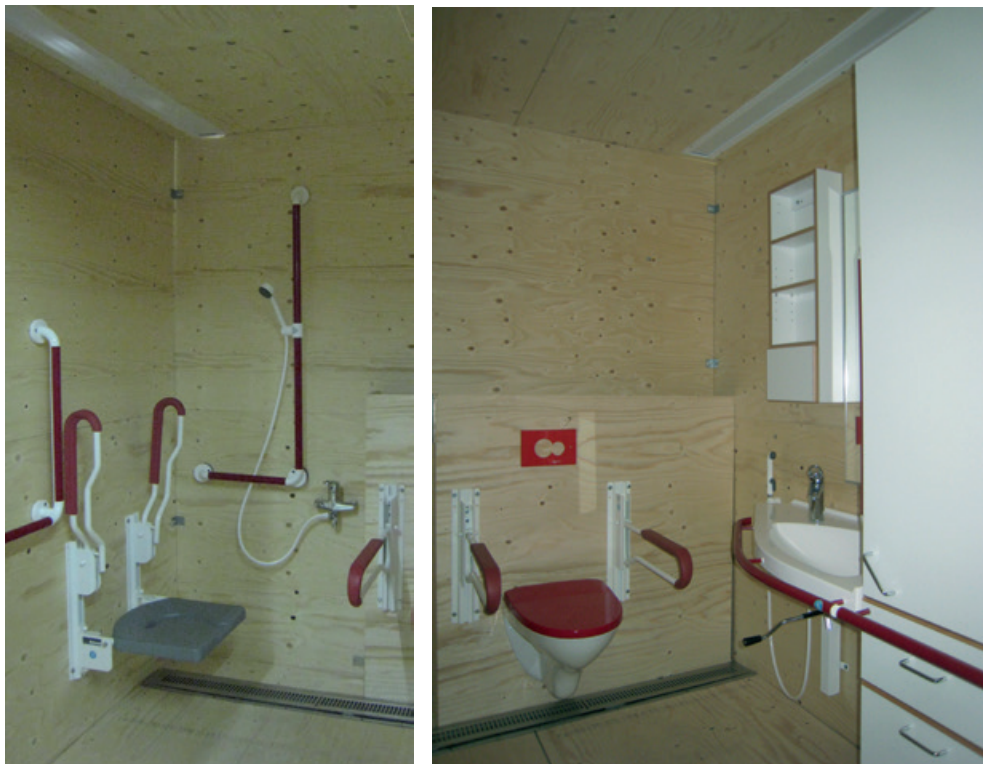
Kuva 18. Koti kaikille -hankkeessa toteutettu vanerinen tilamalli minimi kylpyhuoneesta, jossa on jatkokehitelyjä tai uusia tuotteita käyttäjien testattavaksi.
