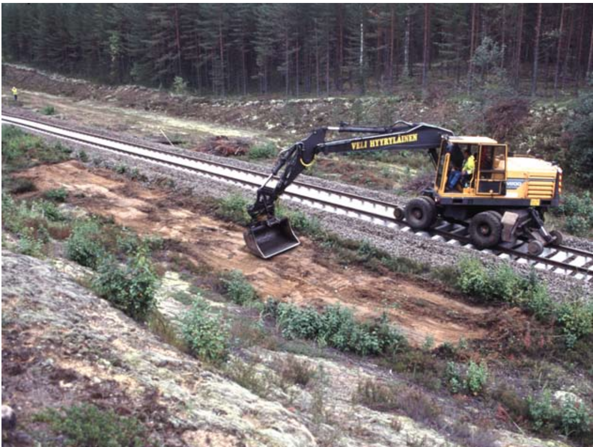
Kuva 18. Lehtipuujuurakoiden poistoa ratakaivurilla Vihurinniemiä kesällä 2000.
