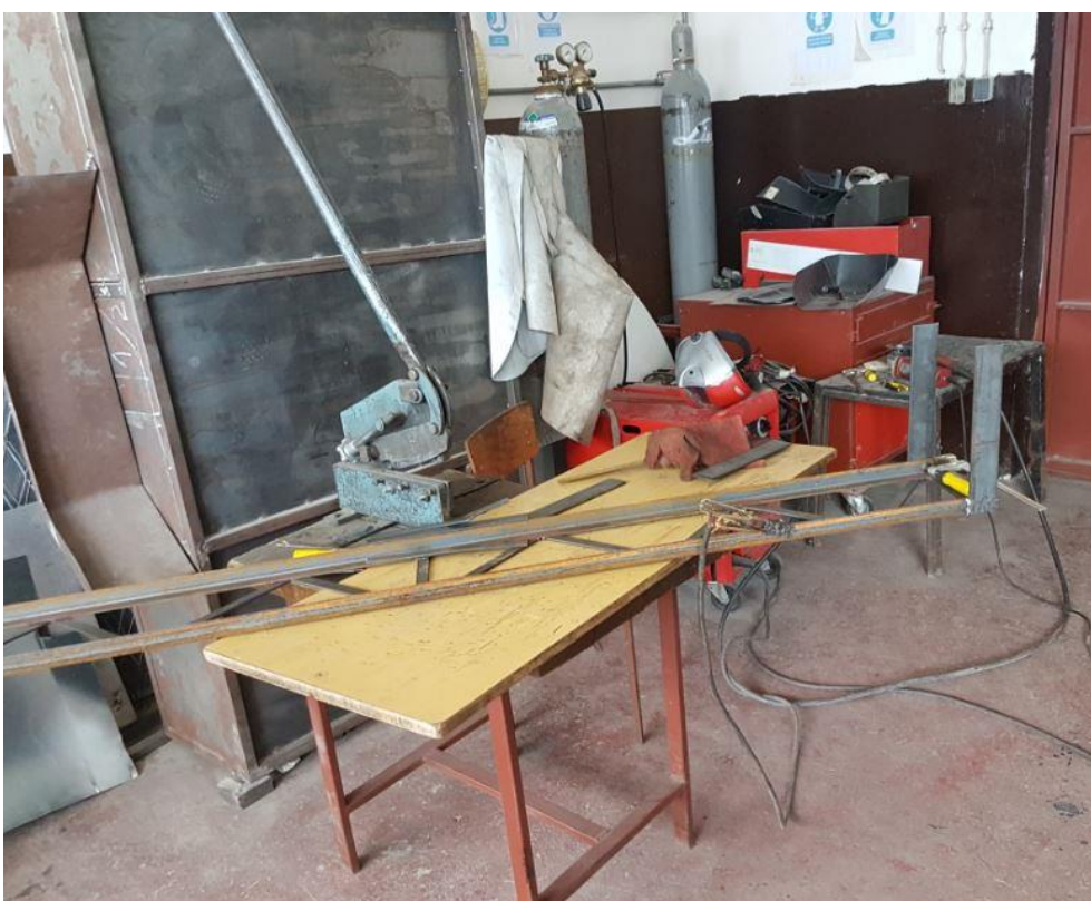
Slika 65.: Početak zavarivanja nosive konstrukcije
