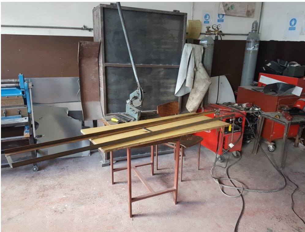
Slika 63.: Priprema za spajanje komponenata nosive konstrukcije
