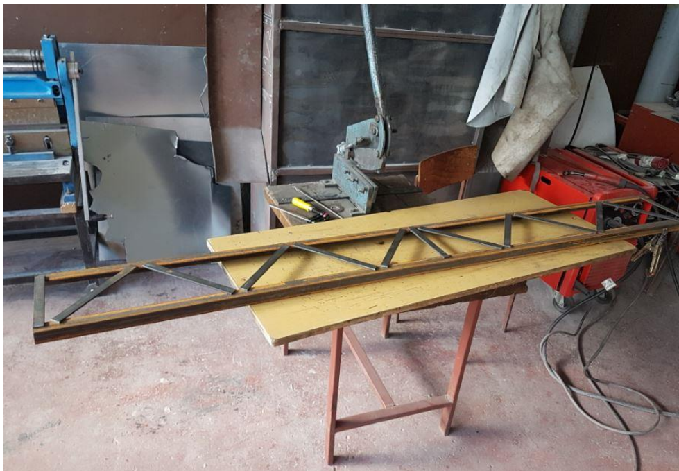
Slika 64.: Postavljanje rešetkastog nosača nosive konstrukcije
