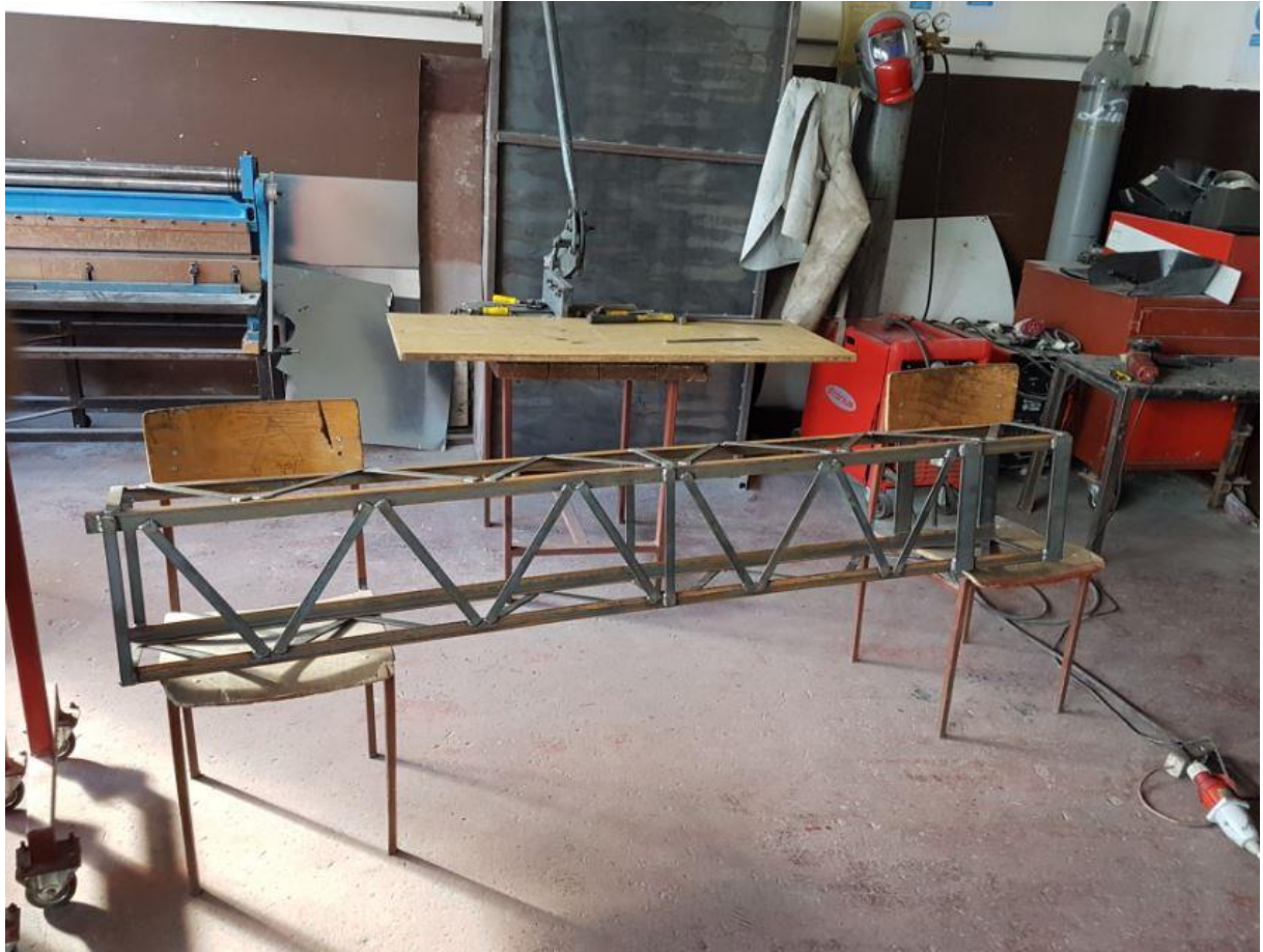
Slika 68.: Zavarivanje ostalih stranica konstrukcije
