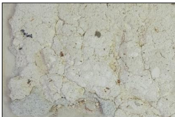
Slika 137. Poledina žbuke intonaca prije ispunjavanja oštećenja nadoknadnom žbukom.
