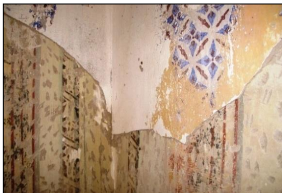
Slika 79. Detalj šablonskog oslika iz 20. stoljeća (gornja zona fotografije) i šablonskog oslika iz 19. stoljeća (donja zona fotografije) u sjeverozapadnoj prostoriji na prvome katu kuće Moise.
