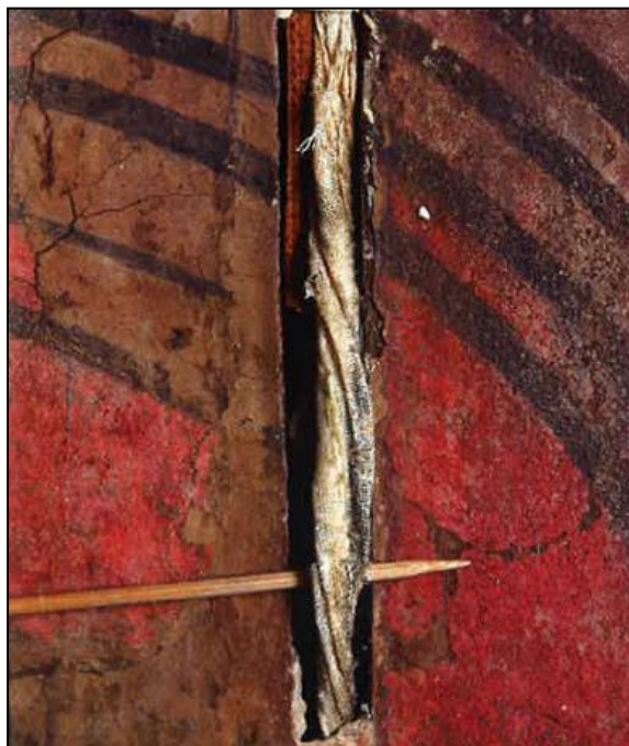
Slika 18. Smotuljak lanenog tkanja kojim su ispunjavani prostori između spojeva masonit ploča 1933. godine.
