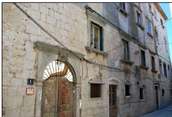
Slika 64. Pogled na sjeverno pročelje kuće Moise u Cresu.
