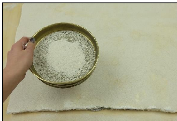
Slika 140. Sipanje vapnenačkog drobljenca na prvi (djelomično upijen, ali još uvijek mokar) sloj vapnenog kazeinata.
