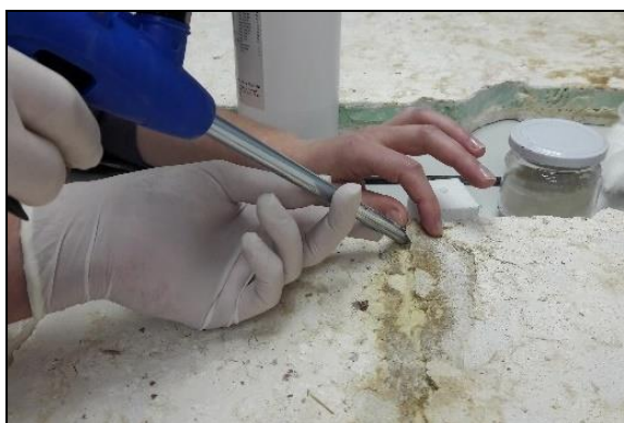
Slika 135. Injektiranje poliuretanske pjene u područje gdje nedostaju žbukani i slikani sloj te gdje su oštećeni facing i poliuretanska pjena nanescena kao dio privremenog nosača.
