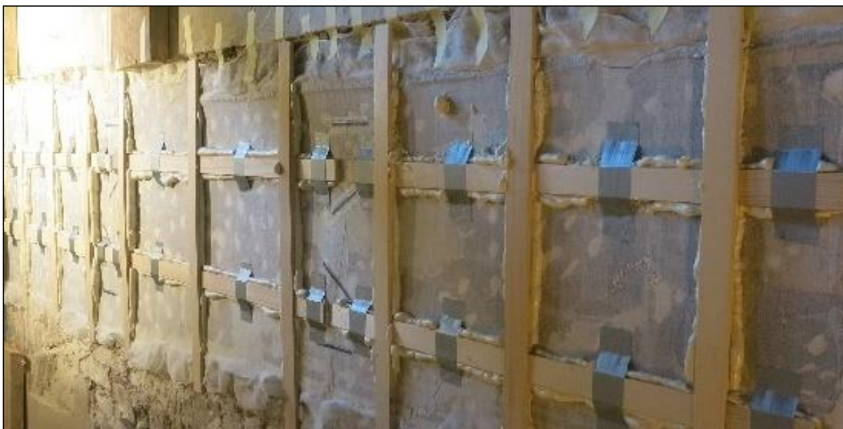
Slika 122. Mreža vertikalnih i horizontalnih drvenih letvica koje su zalijepljene poliuretanskom pjenu.
