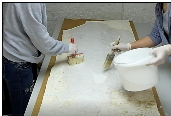
Slika 139. Nanošenje prvog sloja vapnenog kazeinata.
