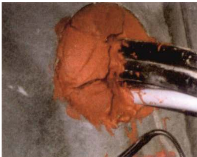
Slika 20. Brtvljenje proboja
