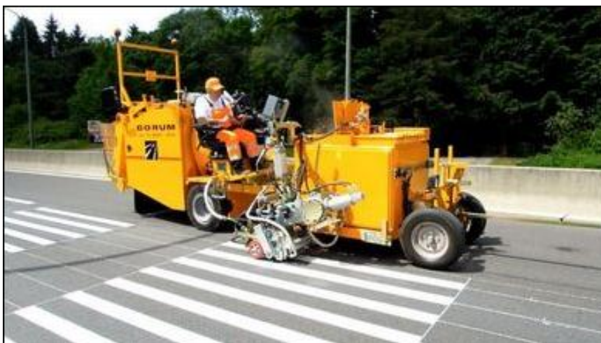
Slika 3. Postupak nanošenja boje na kolnik
