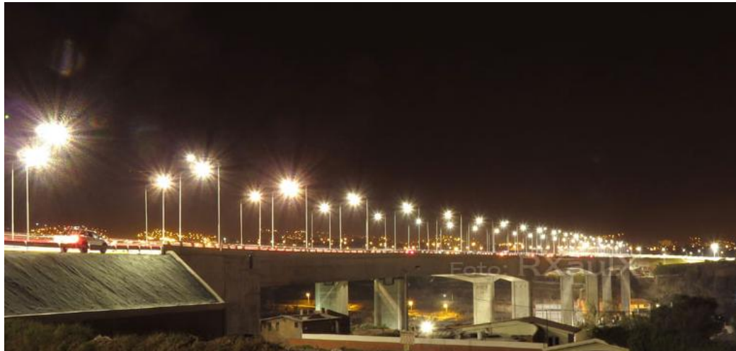
FIGURA 9: ILUMINACIÓN DEL PUENTE CHILINA
