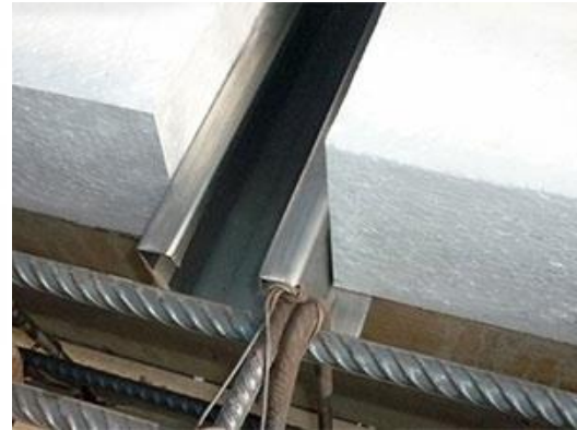
DETALLE ISOMETRICO VIGUETA VIGACERO
