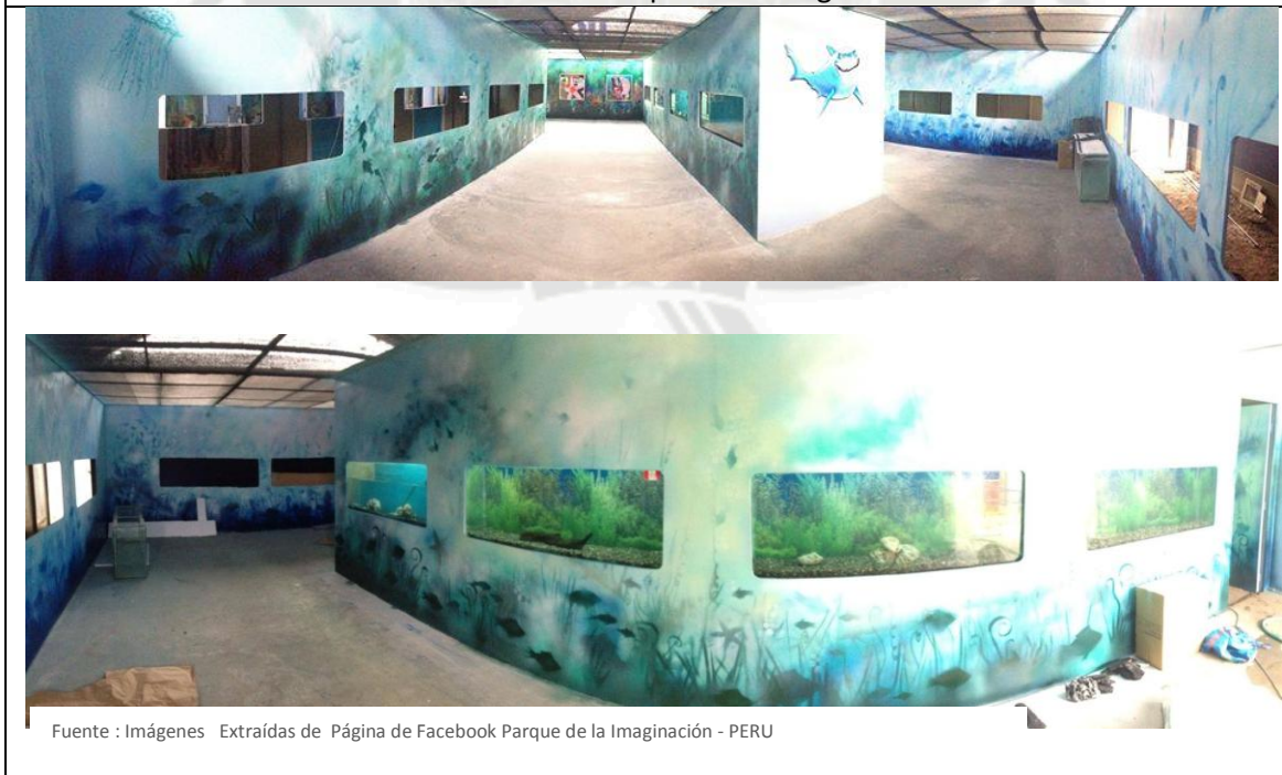
GRÁFICO N°37 : Acuario en Construcción - Parque de la Imaginación
