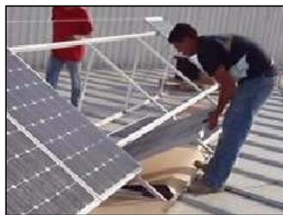
Figura 11.18 Incorrecto acopio del material
