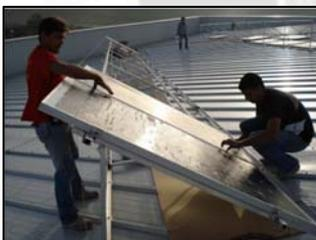
Las placas se recogen del suelo al lado de la subestructura o de debajo de ella, cosa que hacía más difícil la tarea. A medida que pasaba el día el operario que se encargaba de recogerlas y apoyarlas en la subestructura iba disminuyendo su rendimiento físico.
