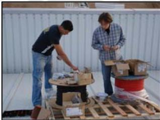
Aquí los trabajadores montaban in situ unos anclajes, que después los unirían a la guía de la subestructura, para aguantar la placa solar.
