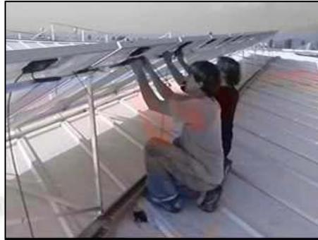
Fig. 9.8 Operarios montando la instalación eléctrica de las placas fotovoltaicas
