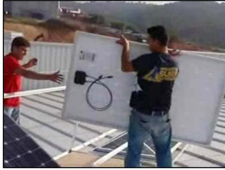
Fig. 9.4 Operario transportando la placa solar por encima de la subestructura
