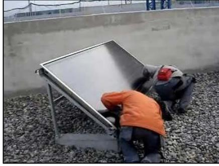
Fig. 9.10. Operarios apretando la placa solar sobre la subestructura
