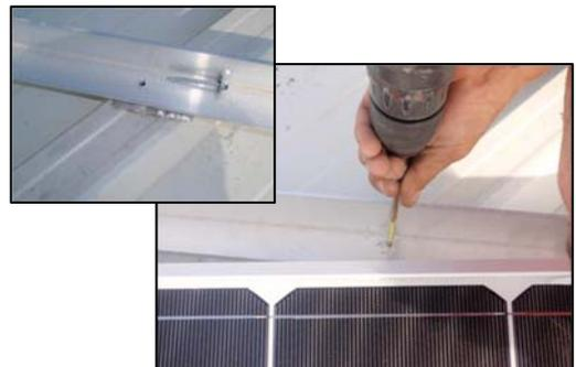
introducir los tornillos, el operario tiene que hacer la máxima fuerza para poder penetrar con el taladro de la subestructura y llegar al forjado. Un problema observado
