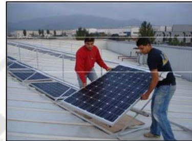
Para nivelar toda la serie de placas, que van a ser insertadas en la subestructura, se usa un hilo atado a cada extremo y un nivelador. A continuación se colocan todas las placas, empezando por un extremo de la subestructura y siguiendo consecutivamente.
