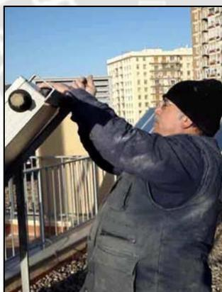
**Fig. 9.13. Operario apretando la placa solar a la subestructura**
