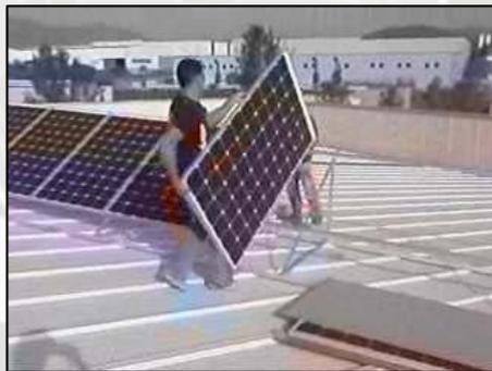
Figura 8.5. Operario transportando la placa solar por encima de la subestructura
