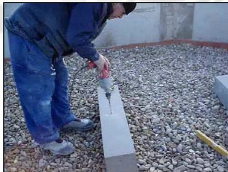
Fig. 9.11 Operario utilizando el taladro sobre la base de hormigón
