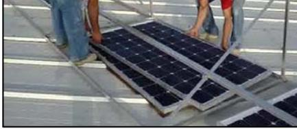
Fig. 9.3. Operarios cogiendo las placas de debajo de la subestructura
