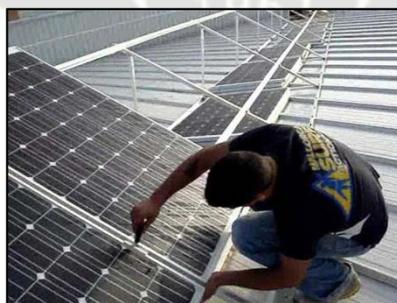
Fig. 9.7 Operario apretando las placas o paneles solares sobre la subestructura
