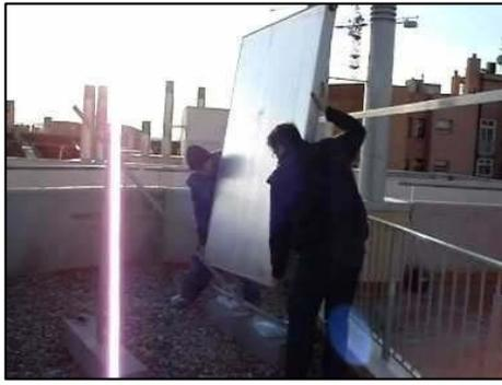
Fig. 9.12 Operarios transportando la placa solar en posición vertical
