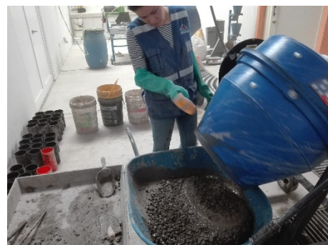
Fotografía 6: Vaciado de Mezcla de Concreto
