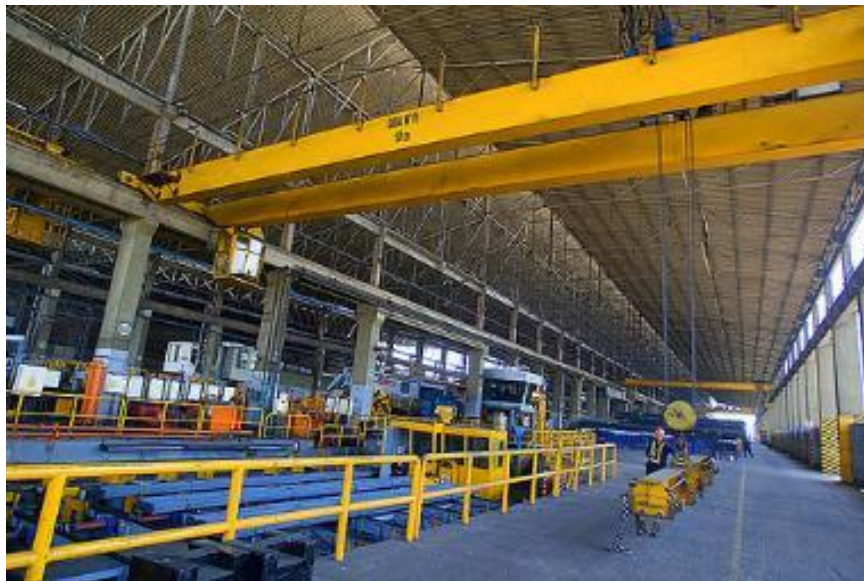
Fotografía 5: Planta de Laminación Fuente: Elaboración propia
