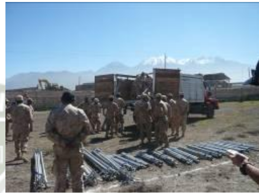
Fig. 18. Instalación del albergue; armado de carpas por personal del ejército y BUSF
