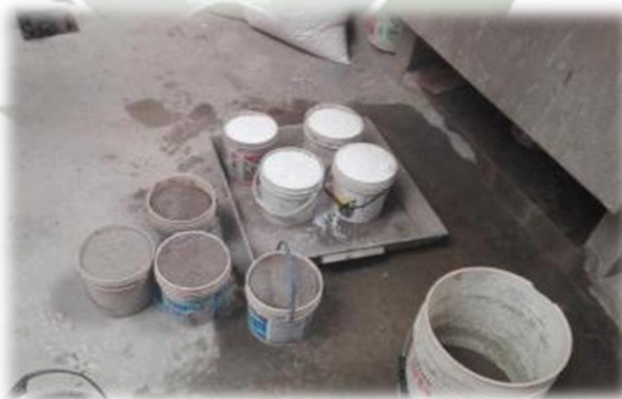
FIGURA N° 40 Los agregados listos para colocar al trompo (Fuente propia).
