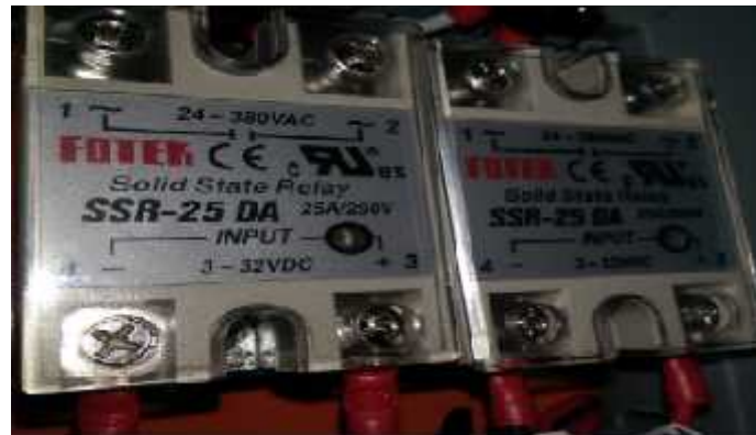
Figura. 3.30 Montaje del SSR con el HEATER Y BLOWER Fuente: Elaboración Propia
