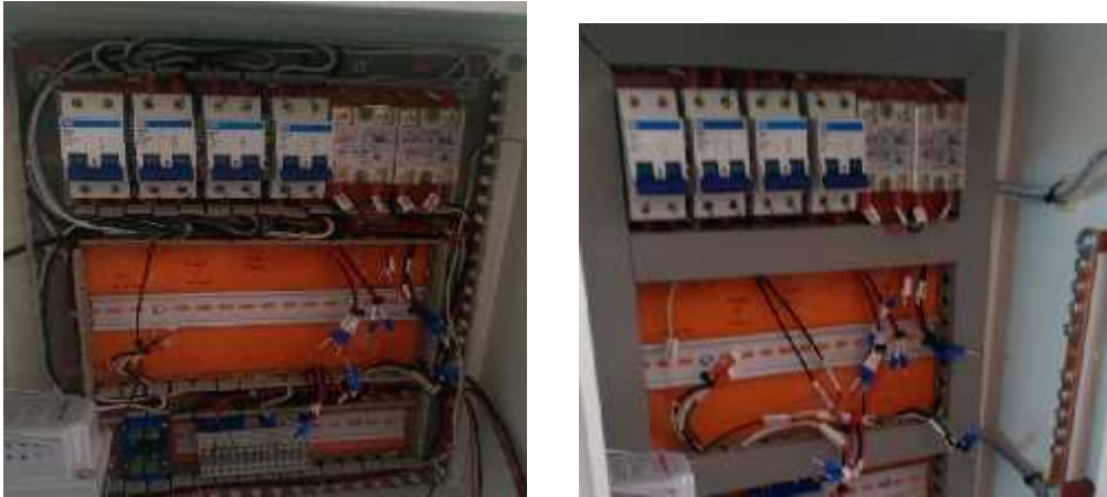
Fig.3.35: Canalización Eléctrica, cableado y conexionado. Fuente: Fotografía
