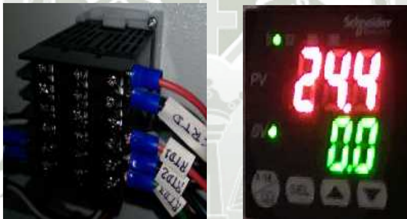
Figura. 3.20 montaje y conexionado del Reg48 Fuente: Fotografía
