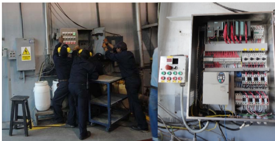
Figura 115: Cambio de Tablero Antiguo por el Tablero Nuevo
