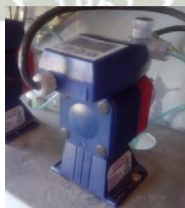
Figura 27: Bomba de Químico de Agroindustrial del Perú
