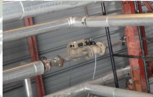
Figura 107: Línea de Ingreso de vapor Modificado
