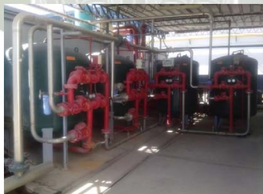
Figura 22: Proceso de Filtrado de Agroindustrial del Perú
