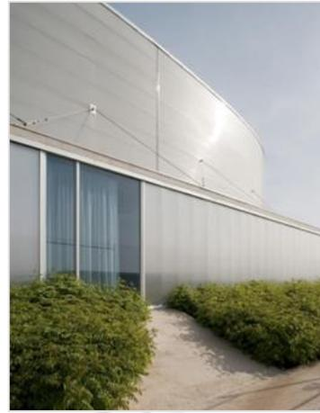
Los materiales empleados para el cerramiento exterior del edificio son sintéticos (ver Foto 37), una composición de dos capas en la que la piel interior actúa como reflejo de la orientación geográfica de la fachada: plásticos azules y verdes para la zona Norte y amarillos para Sur y Oeste (ver Foto 38).
