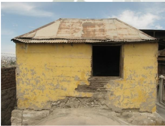
Figura 32: Habitación sobre el bloque Este.
