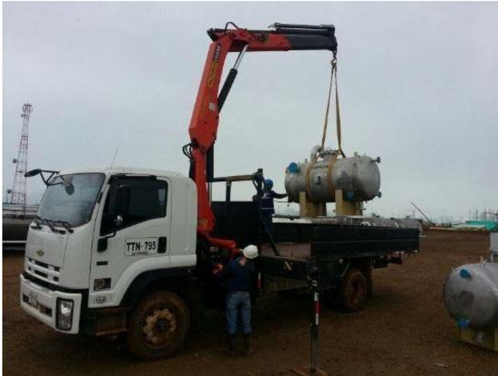
Imagen N° 4-5 GRUA DE 15 TN
