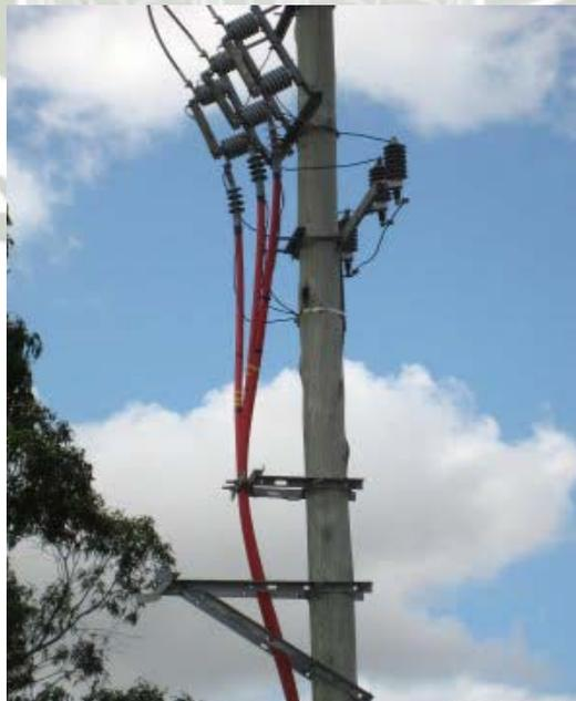
Fig. N° 07: Vista de una acometida en media tensión tipo aérea
