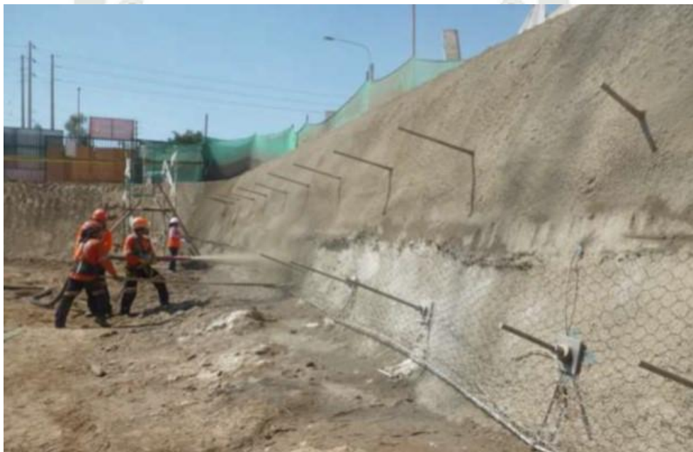
Ilustración 24. Lanzado de shotcrete.
