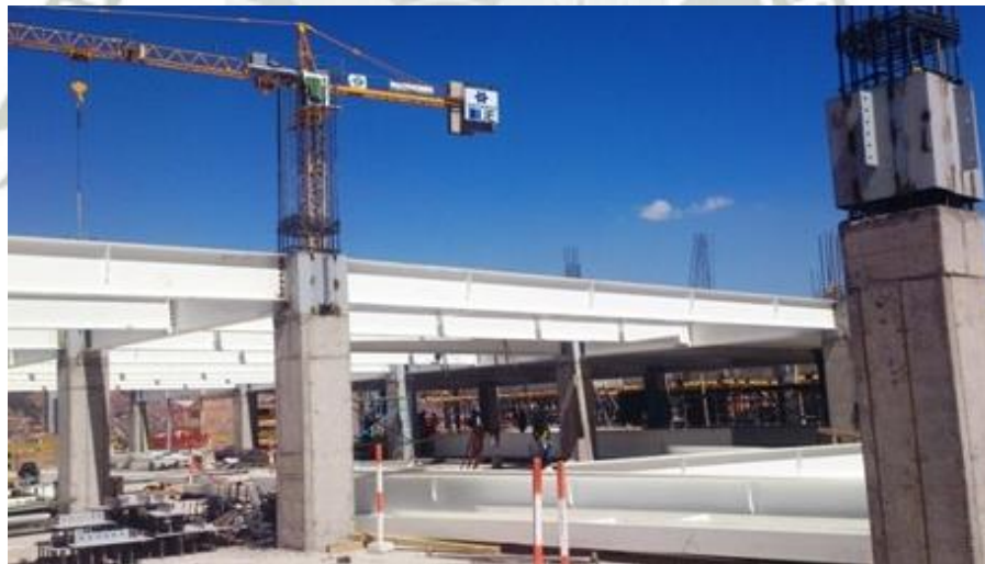
Ilustración 16. Se Observa el montaje de las vigas Metálicas
