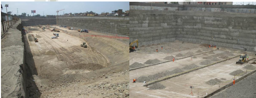
Ilustración 21. Excavación y estabilidad de talud
