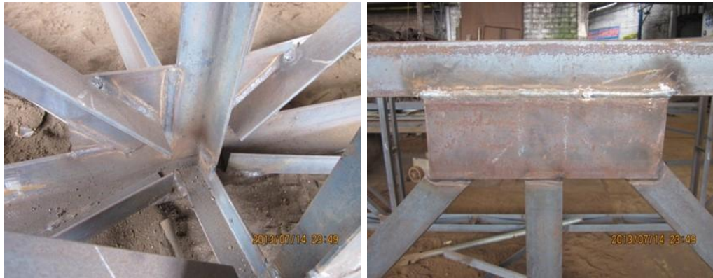
Ilustración 12. Verificación visual de soldadura
