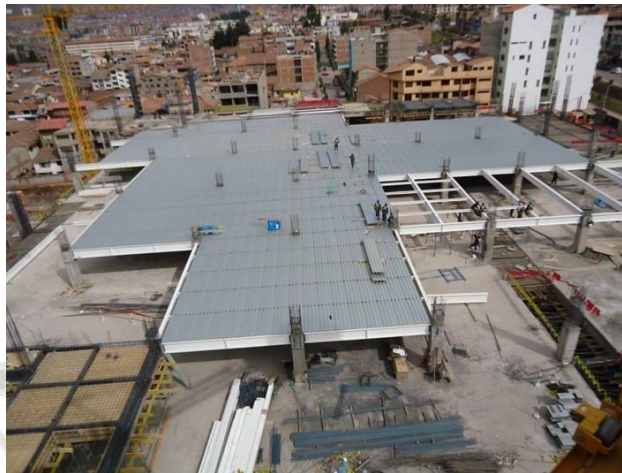
Ilustración 17. Se observa la colocación de placa colaborante sobre vigas metálicas.
