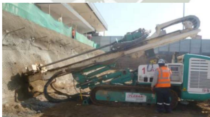
Ilustración 23. Perforación y colocación de pernos Nails.
