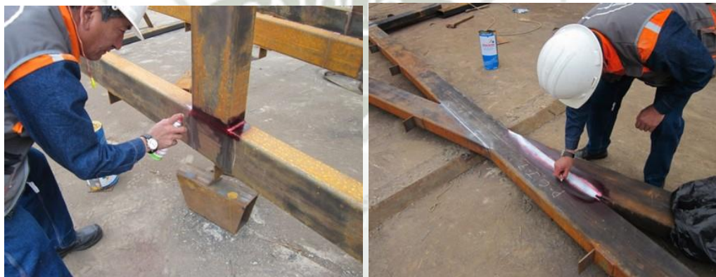
Ilustración 13. Inspección por Líquidos Penetrales
