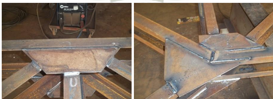
Ilustración 11. Verificación visual de soldadura
