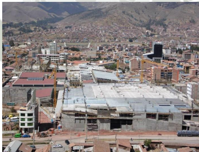
Ilustración 18. Se observa la losa colaborante de 7,000 m 2 con el vaciado de concreto al 60%
