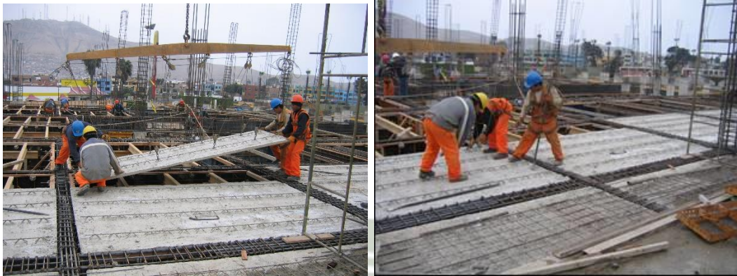
Ilustración 26. Montaje de Prelosas Macisas
