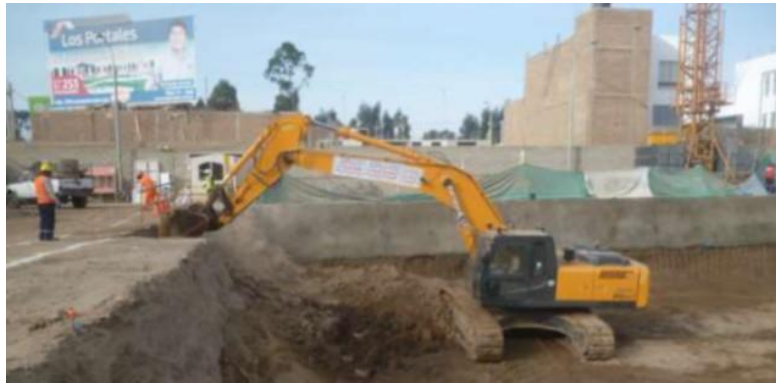
Ilustración 22. Primera etapa de excavación
