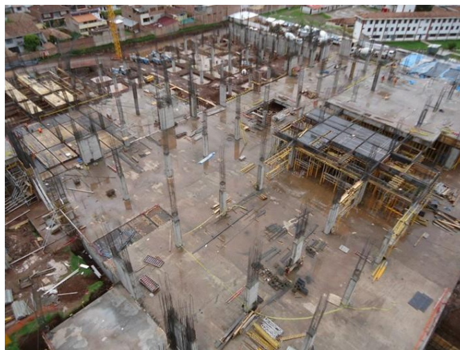
Ilustración 4. Panorámica Sector G primer nivel (N+/-0.00) y Sector F (N-3.50) sótano.
