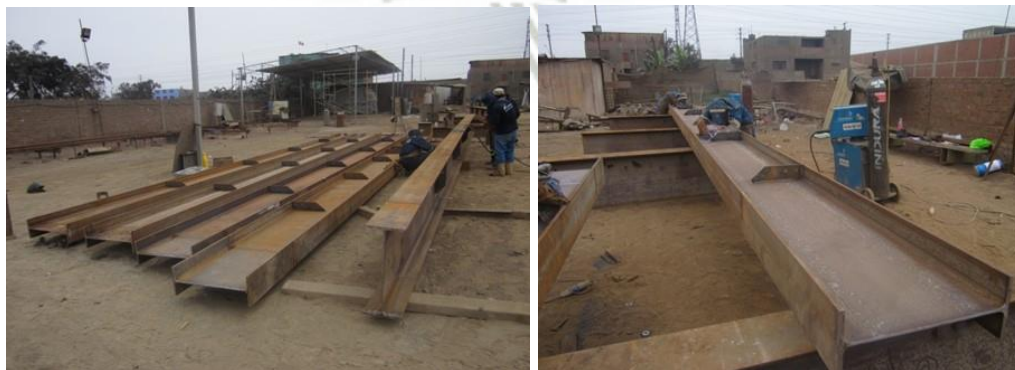
Ilustración 14. Verificación del arenado de las vigas W30X124
