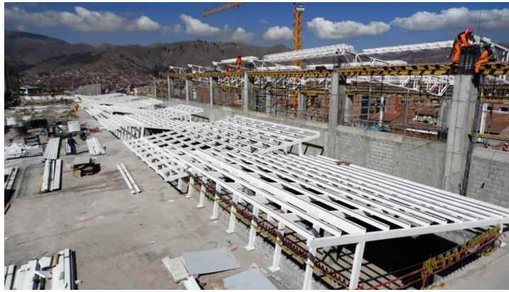
Ilustración 6. Techos cobertura Metálica liviana 10,145m 2 .
