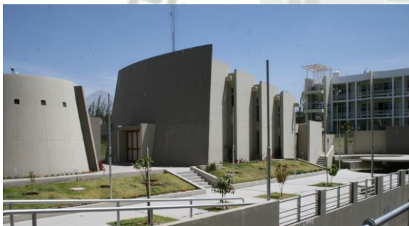
IMAGEN Nº 26: Auditorio, Vista desde el patio principal FUENTE: Fotografía propia
