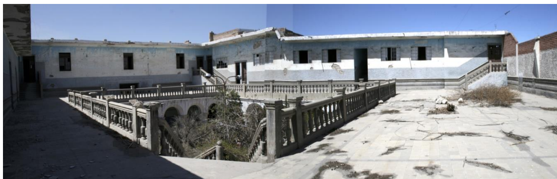
IMAGEN N° 42: Claustro principal del Ex colegio San Francisco, Segundo Nivel FUENTE: Fotografía propia
