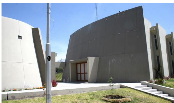
IMAGEN Nº 24: Auditorio, Vista desde el patio principal FUENTE: Fotografía propia
