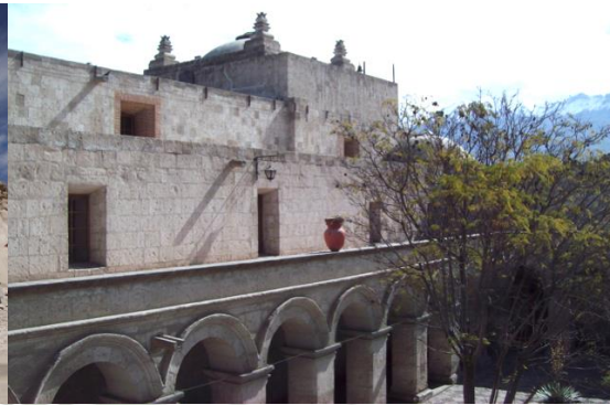
IMAGEN N° 77: Claustro central del Convento de San Francisco, Arequipa FUENTE: Fotografía propia
