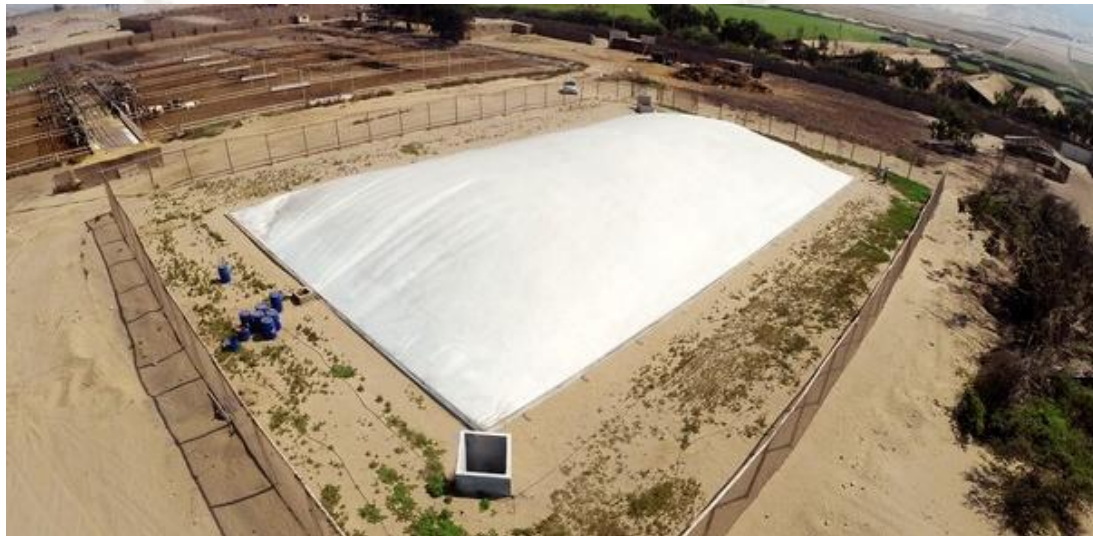
Figura 7. Biodigestor tipo laguna instalado en Trujillo con capacidad de 4500 m 3 . (CIDELSA)
