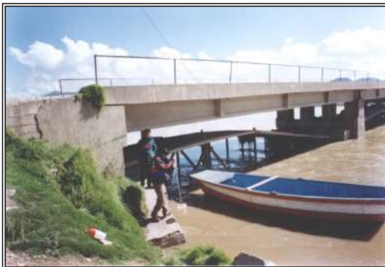
FIGURA N° 1: Puente Ramis, lugar de desembarque de pescadores.
