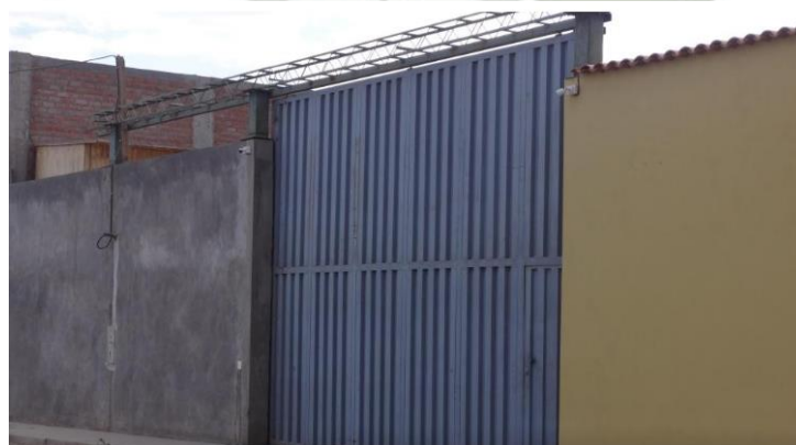
Figura N° 133: Local Río Seco
