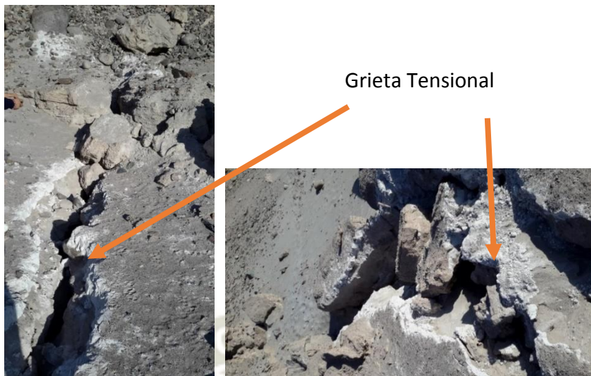
FIGURA 5.22. Foto de grietas tensionales en la base del talud.
