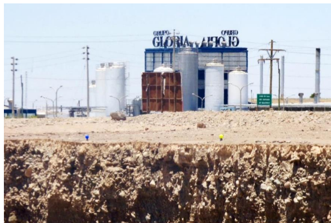
FIGURA 5.11. Vista de la planta de leche Gloria, infraestructura amenazada por avance del deslizamiento.
