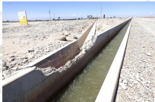
FIGURA 5.13. Trazo del canal de Irrigación aperturado para febrero del 2017.
