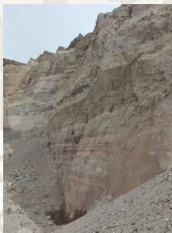
FIGURA 5.21. Foto de un costado del talud, Año 2018.
