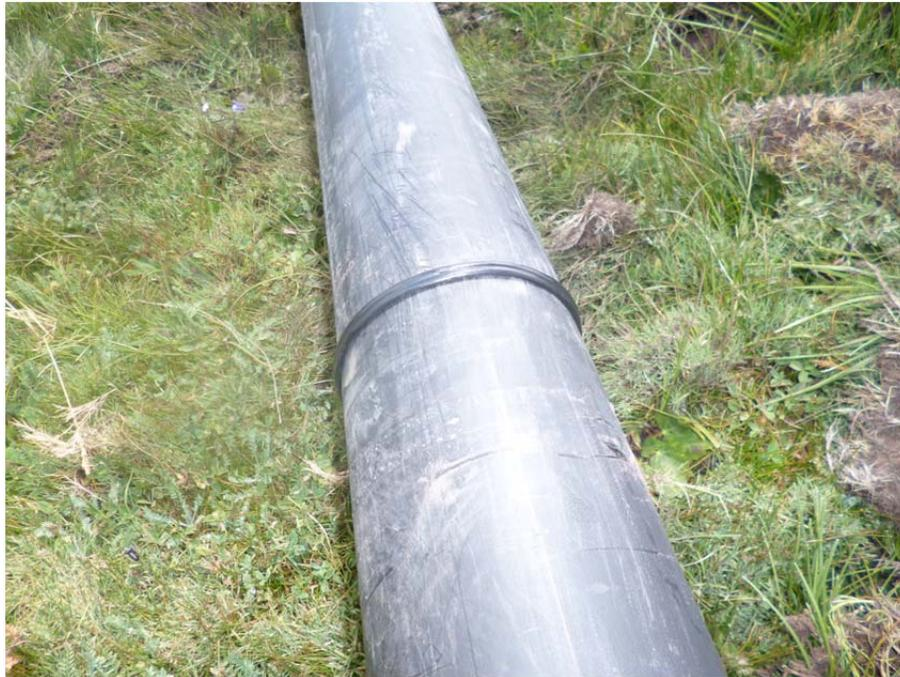
Unión de dos tuberías por electro fusión
