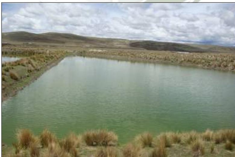
Foto 03: Lagunas primarias de oxidación sin Mantenimiento
