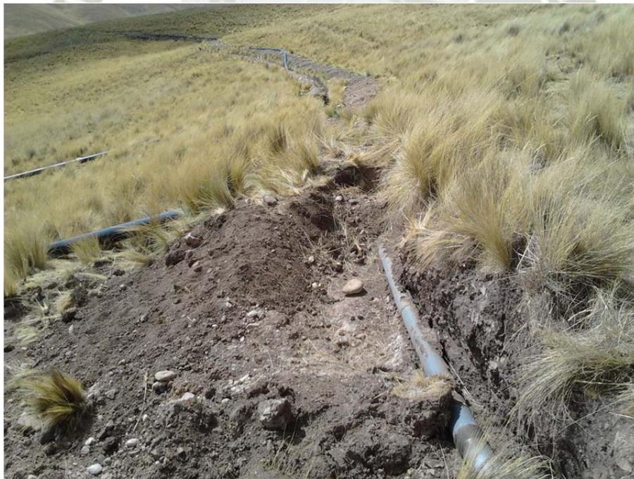
Reparación de una tubería de PVC en la línea de conducción
