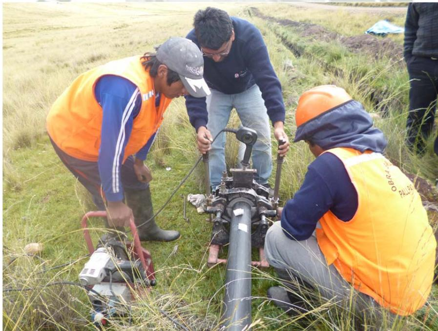
Electro fusión para unión de dos tuberías.
