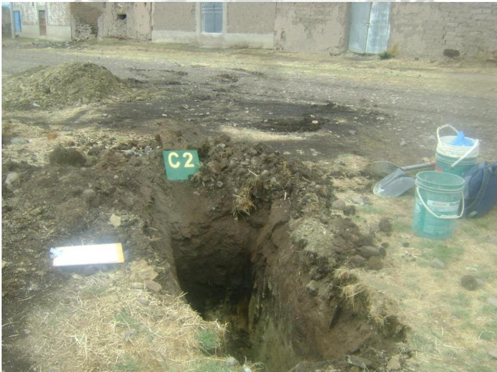
Figura 2. Excavación de la Calicata C-2.
