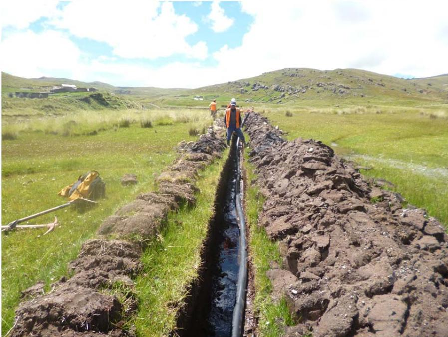
Tendido de tubería HDPE en un humedal, con agua anegada
