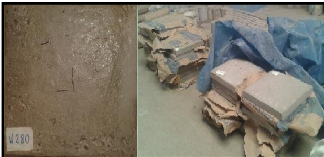
FIGURA 5.4 Losetas de fisuración
