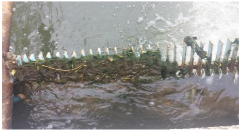
Foto 1: macroalga en los pozos y canales de la empresa de generación eléctrica de Arequipa
