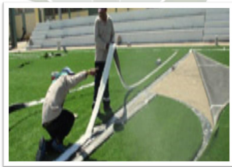
Ilustración 10. Colocación de línea de delimitación.
