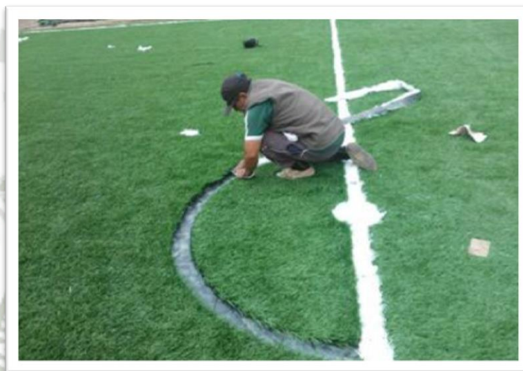
Ilustración 11. Colocación de línea circular de punto penal en cancha de fútbol.
