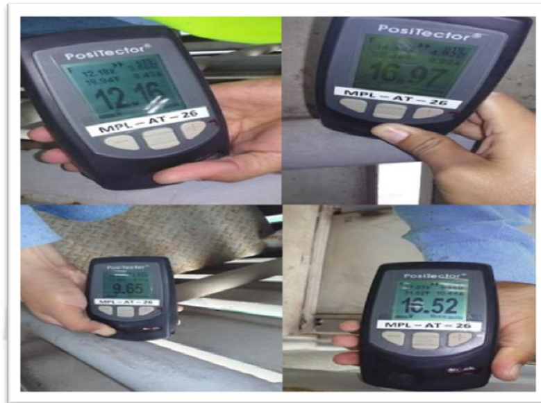
Ilustración 23. Medición de espesores de pintura.
