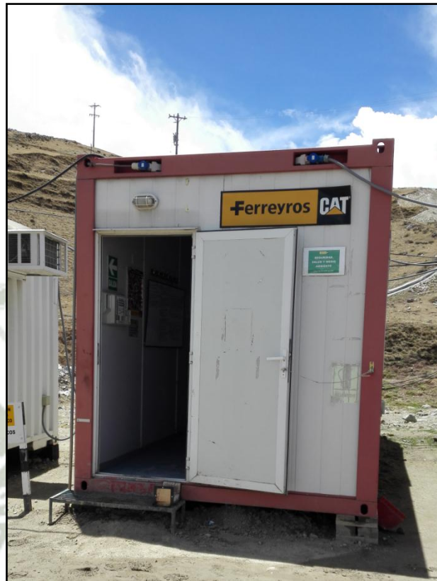
Fotografía 32: Medición niveles de iluminación oficina de seguridad
