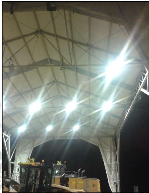
Fotografía 54: Medición de niveles de iluminación en Hangar Fase 5
