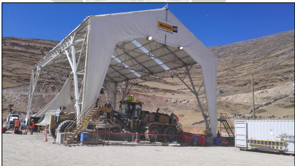
Fotografía 55: Medición de niveles de iluminación en Hangar Fase 5
