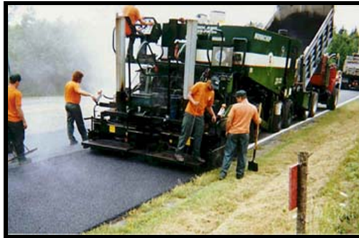
FIGURA 2. 8. Colocación de mezcla asfáltica. (KRAEMER, 2002)
