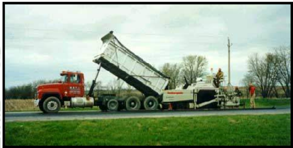
FIGURA 2. 7. Transporte de mezcla (KRAEMER, 2002)
