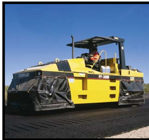
FIGURA 2. 14. Compactación Final (KRAEMER, 2002)
