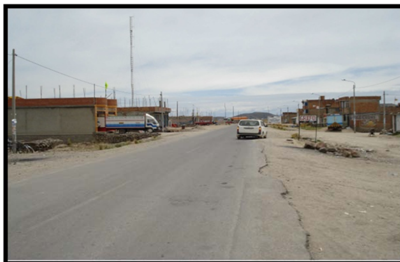
FOTO 4. 1. Inicio del tramo Km 0+000 en Chacachaca .
