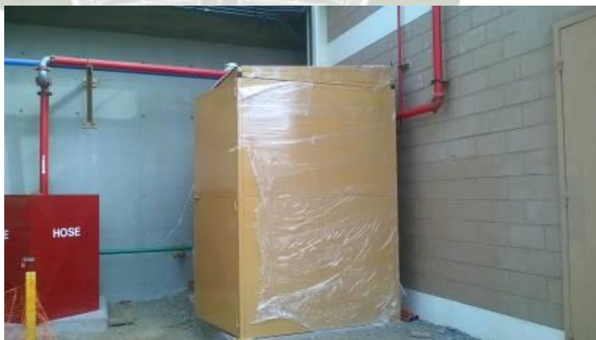
Imagen "13": Caseta FM-200 Exterior Sala Eléctrica Principal (Creación Propia).
