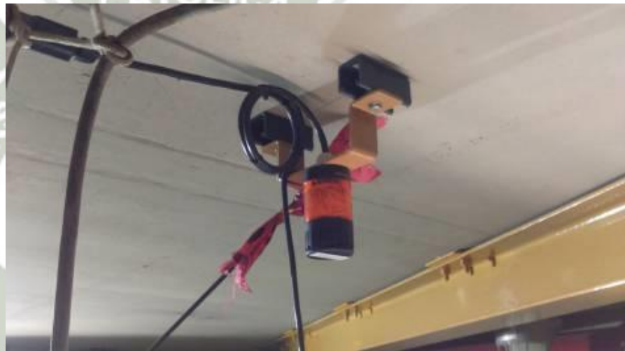
Imagen “29”: Sirena/Baliza en Belt Feeder (Creación Propia).
