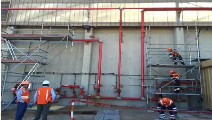
Imagen "14": Lado Sur – Exterior Nave Industrial (Creación Propia).
