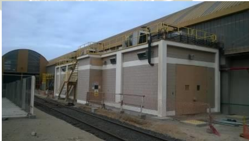
Imagen "11": Exterior Sala Eléctrica Principal (Creación Propia).
