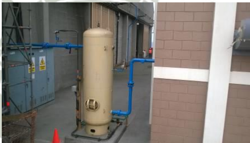
Imagen "10": Tanque Pulmón 3211-ST-001 (Creación Propia).
