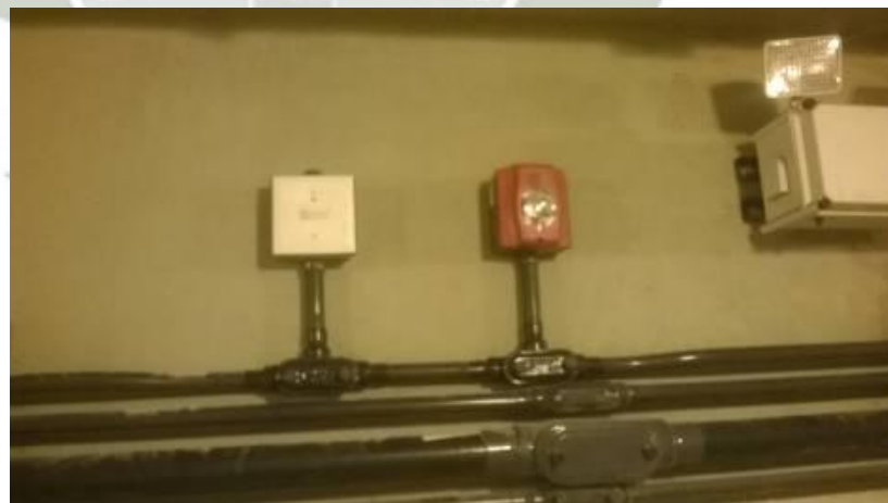
Imagen “37”: Sirena y Luz Estroboscópica (Creación Propia).
