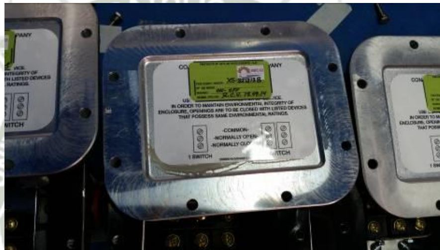
Imagen “23”: Sticker colocado en Laboratorio (Creación Propia).
