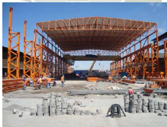
Imagen "4": Montaje Estructural (Grúa Puente).
