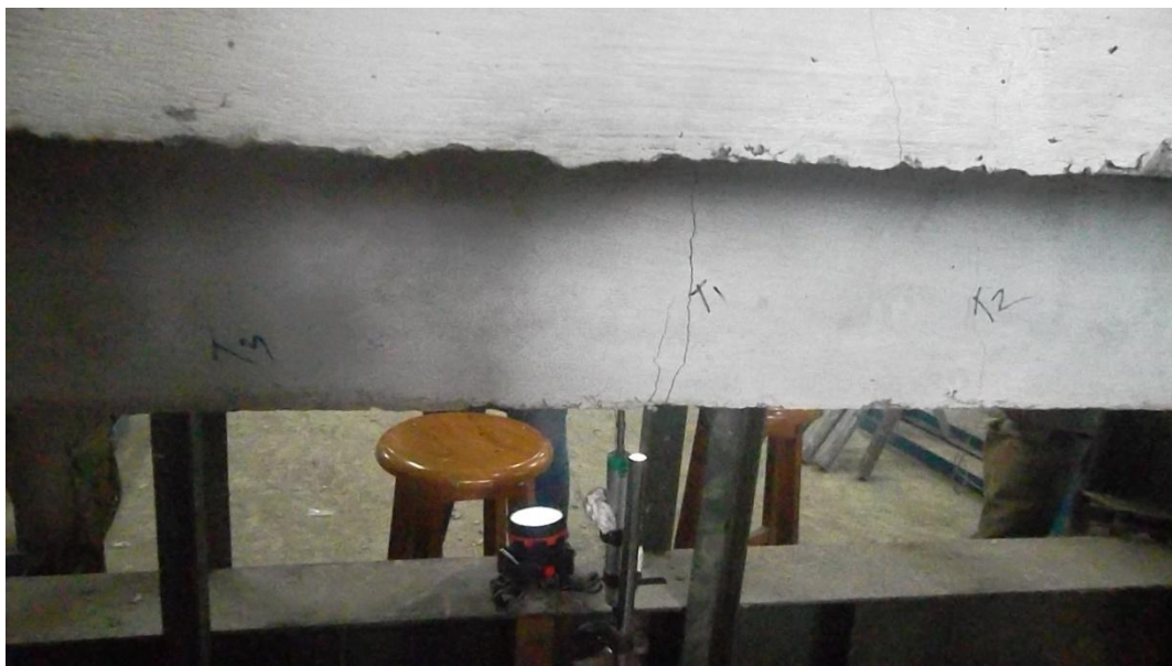
Gambar 4.41 Pola retak balok tanpa sambungan (BTS)-B
