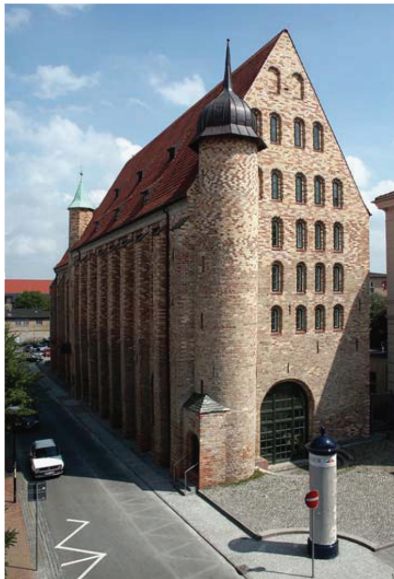
Abbildung 6 Michaeliskloster: Fachbibliothek Geschichte vor (oben) und nach (unten) der Sanierung
