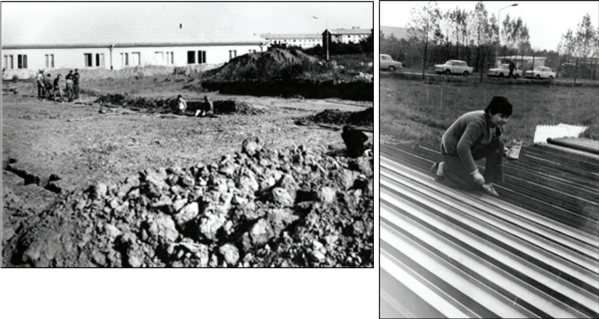
Abbildung 9 Bau einer Leichtbauhalle in Eigenleistung 1971
