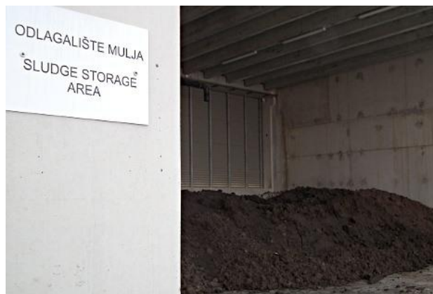
Slika 13. Odlagalište mulja na pročistaču u Karlovcu
