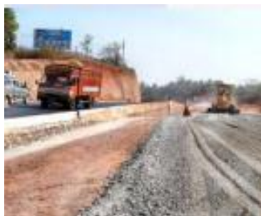
Slika 19. Primjena mulja kod izgradnje prometnica
