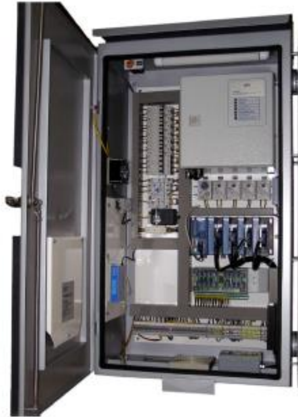
Ilustracija 9. Ormar informacijskog sustava motrenja
